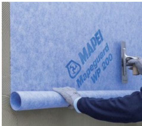
Τοποθέτηση Mapeguard WP 200
