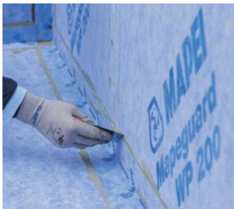
Εφαρμογή του Mapeguard ST
