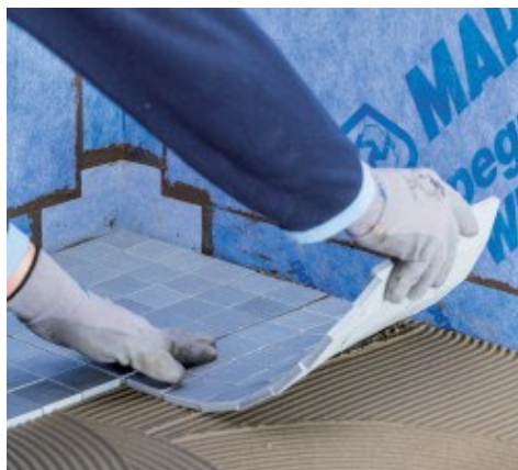
Τοποθέτηση των πλακιδίων
